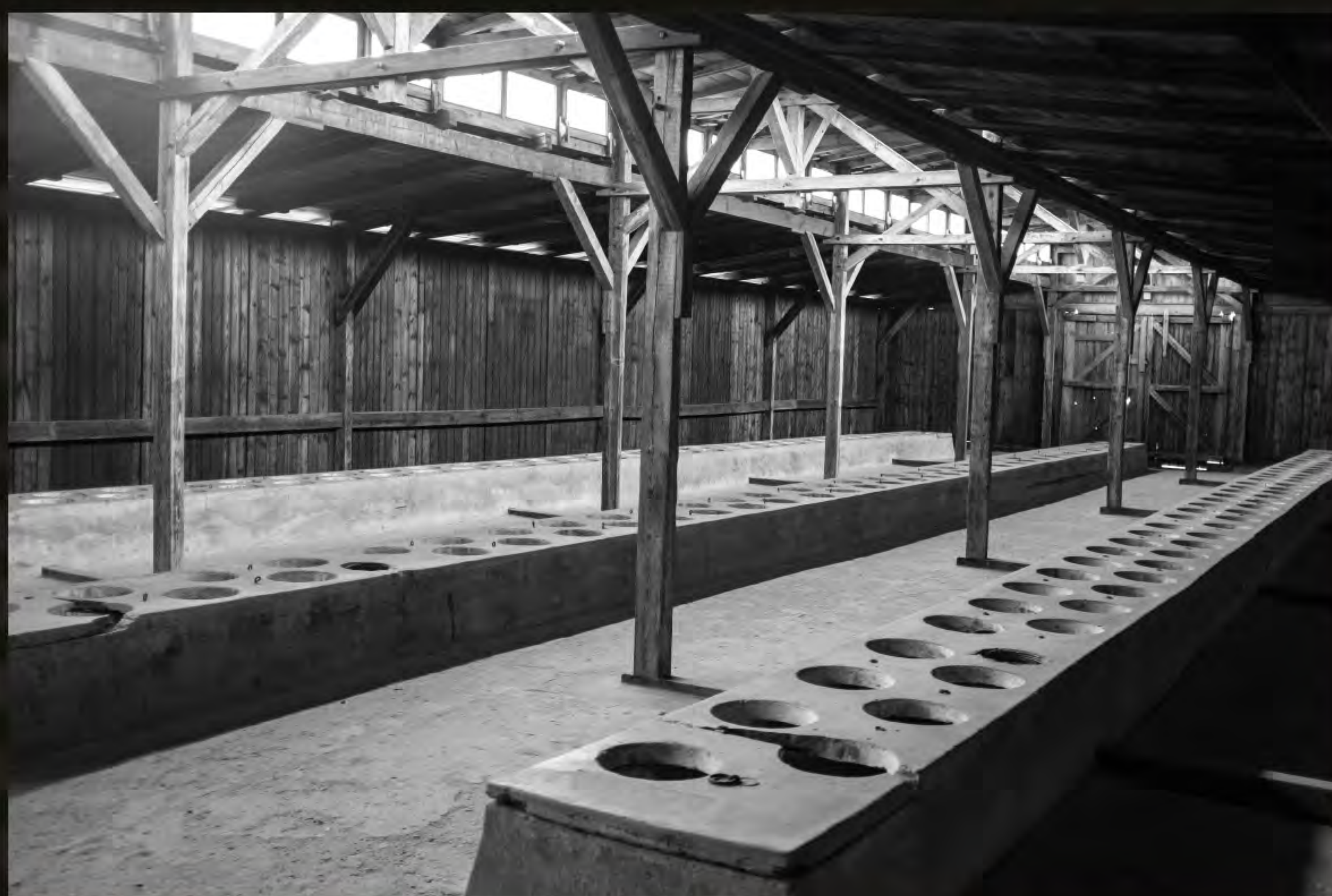
Des bâtiments « latrines » et des lavabos entrent en service en 1943. Leur conception est rudimentaire : de simples rigoles d'écoulement recouvertes d'une plaque de béton, avec une centaine de lunettes circulaires.
