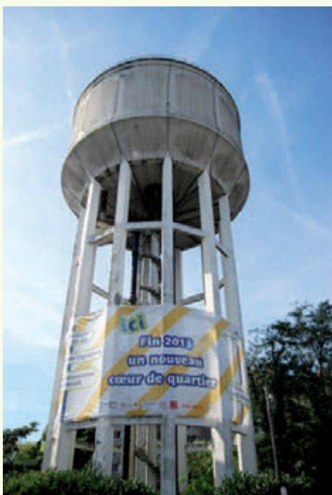
Le château d'eau : emblème du Bel-Air.
