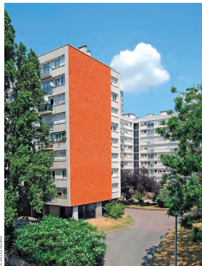
Cet été, à La Noue, coupures d'eau à rallonge et incidents de chantier.
