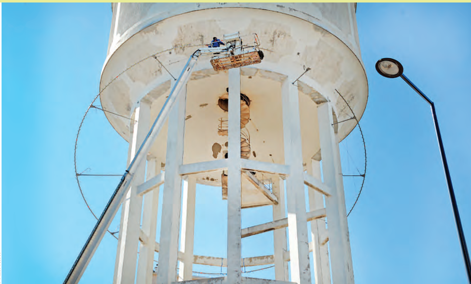
Pose des systèmes d'accroche et des cerceaux de 17 mètres de diamètre autour du château d'eau pour l'installation de Modern Dance , l'œuvre de l'artiste montreuillois Claude Lévêque.
