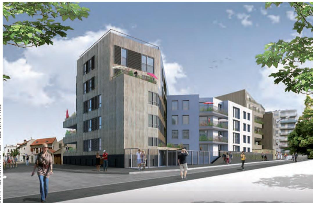
Façade à ossature bois, triple vitrage, panneaux solaires en toiture... Le Belvédère rue Eugène-Varlin affichera, en comparaison avec les moyennes observées ailleurs, des consommations énergétiques divisées par dix.
