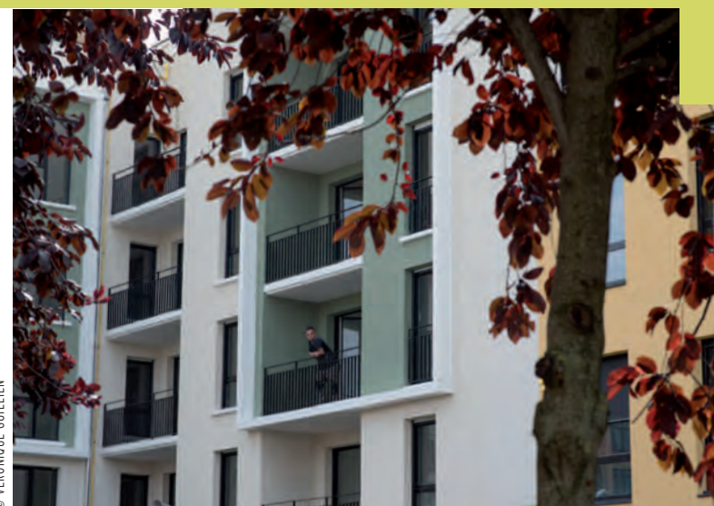
42 logements, dont 22 acquis par l'OPHM, et 3200 mètres carrés de bureaux pour l'URSSAF : une opération qui mêle habitat et activités.
