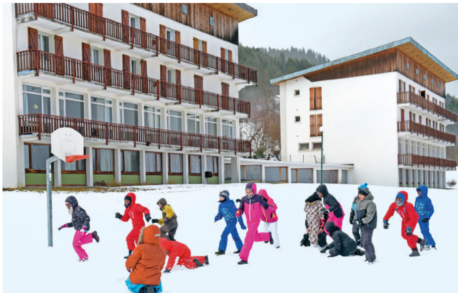
Aujourd'hui, les bâtiments comprennent une salle informatique, un labo scientifique...
