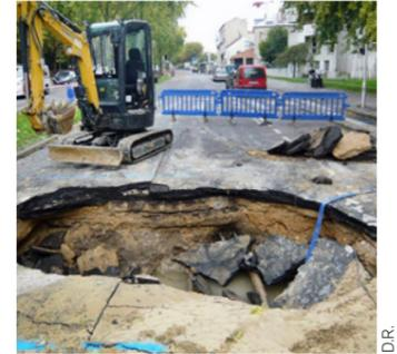
L'avenue de la Résistance a dû être fermée à la circulation dans le sens sud-nord (de la Croix-de-Chavaux vers l'A3) entre la rue Ariste-Hémard et la rue Hoche, jusqu'au 16 octobre. En cause : la rupture d'une canalisation d'alimentation en eau potable sous l'avenue. La fuite d'eau a provoqué un ravinement puis un effondrement de la chaussée. Pendant ce temps, la circulation était déviée par les rues Parmentier, Désiré-Préaux, Hoche, Douy-Delcupe et du Clos-Français.
