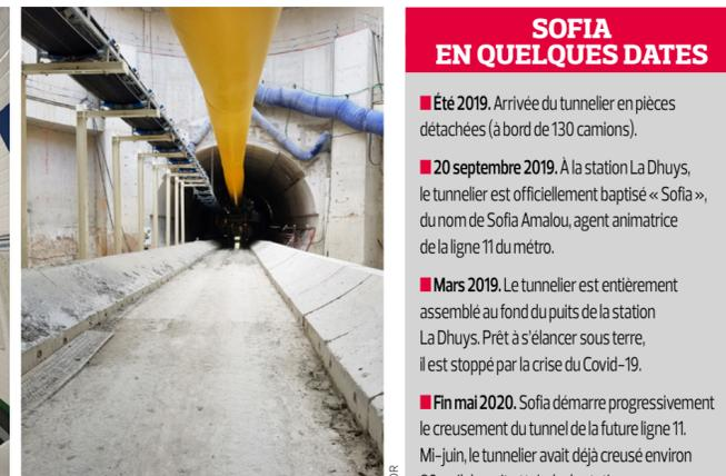
Impressionnant vu de l'extérieur, le chantier l'est plus encore en sous-sol. Parti de la station La Dhuy, le tunnelier Sofia va creuser sur une distance de 3 km, à une profondeur allant de 10 à 24 m, en direction de la future station Serge-Gainsbourg, aux Lilas.
