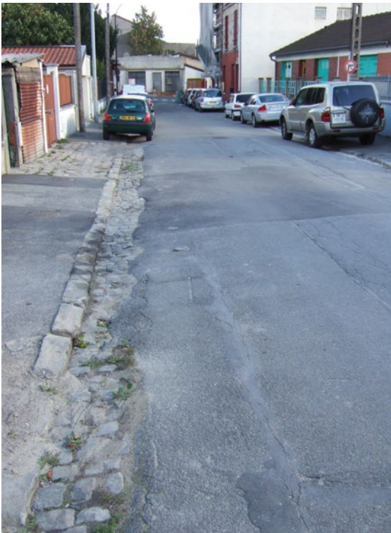
La rue du Moulin-à-Vent, avant et après les travaux. Aujourd'hui une zone embellie et apaisée que se partagent véhicules et piétons.
