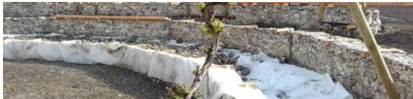
amphithéâtre en construction
