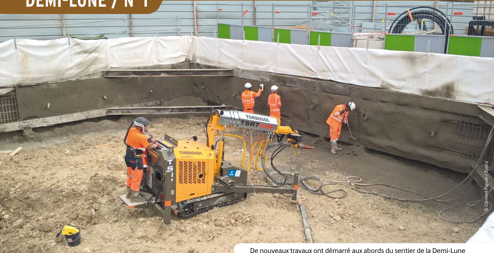
De nouveaux travaux ont démarré aux abords du sentier de la Demi-Lune
