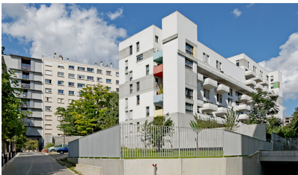
20-22 rue Walwein - 80 logts - 1999 SAEI Montreuilloise d'habitation - Vincen Cornu
