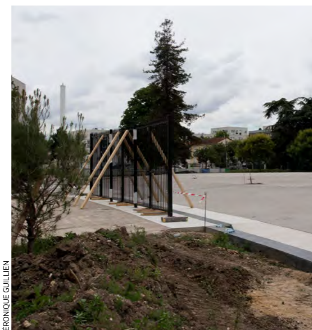
Travaux aux Ruffins.
