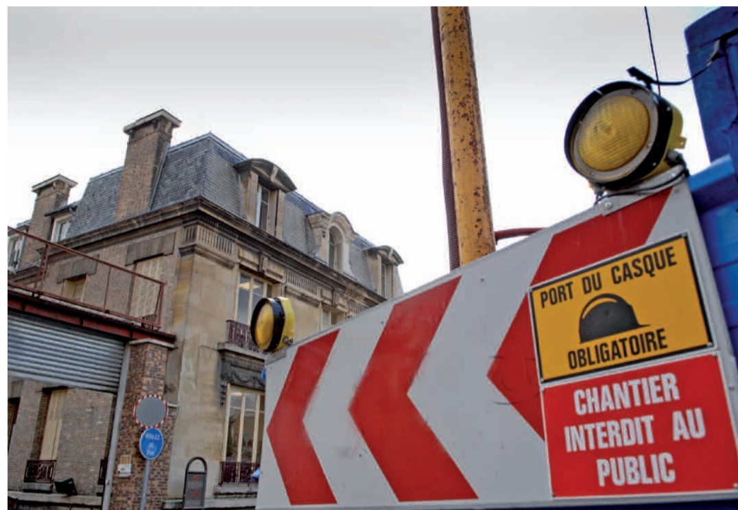
La maison de maître au 91, rue Marceau serait préservée.
