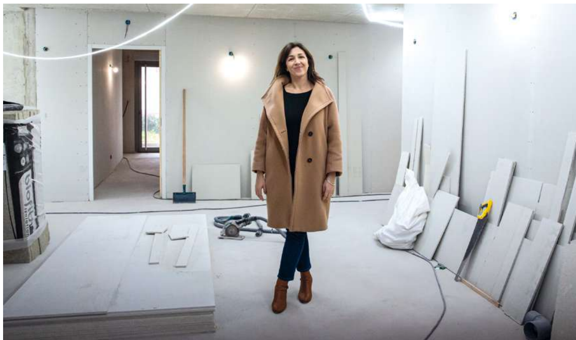
Maud Ferrer, directrice de l'Aktéon Théâtre, rue Alexis-Pesnon, actuellement en travaux.
