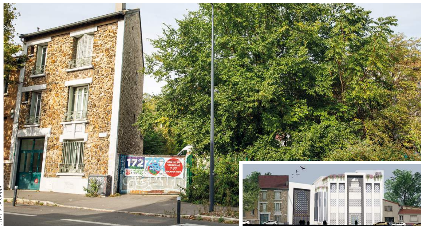
170-172, boulevard de Chanzy, où la nouvelle mosquée sera construite. Ci-dessus, image de synthèse de l'avant-projet.
