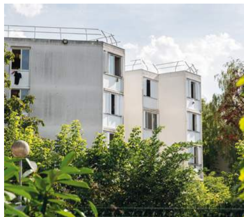
Le foyer de travailleurs migrants Branly, 73, rue Édouard-Branly.
