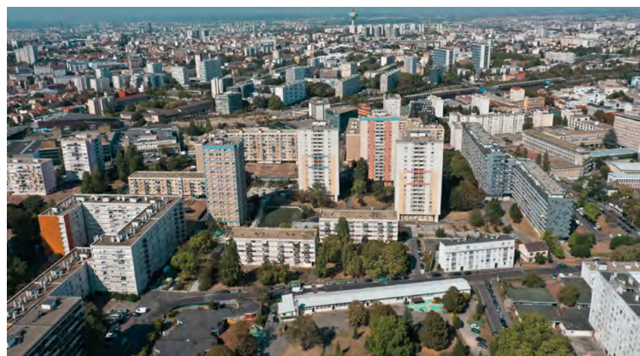
Les travaux au Clos-Français débuteront dès le premier trimestre 2023.
