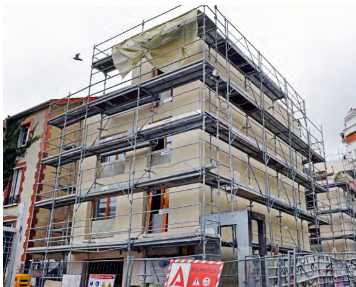
Les locaux de l'EIMA actuellement en chantier, rue Parmentier.
