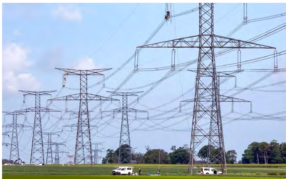
Pour éviter le délestage, il s'agit de réduire la consommation électrique des équipements municipaux.
