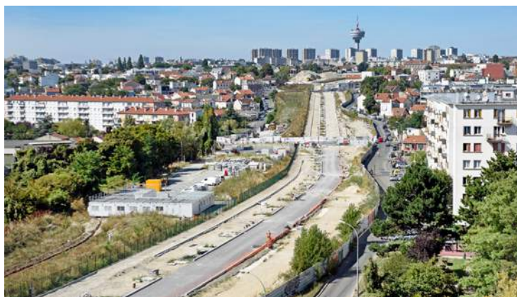
La démolition de l'A186 a libéré près de 4 hectares de terres.
