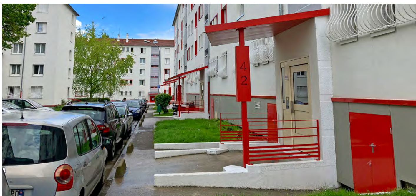
Au Morillon, la Ville poursuivra la rénovation des résidences Montreau, en concertation avec les habitants.
