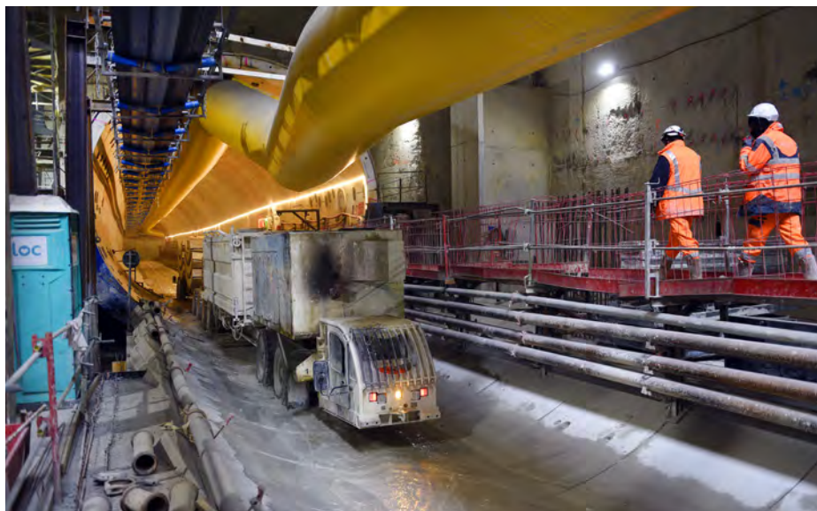
Vue du chantier de la station Montreuil-Hôpital.
