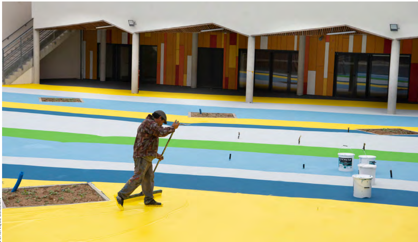
Durant l'été, un revêtement en résine acrylique a été installé sur le sol de la cour de récréation du groupe scolaire.
