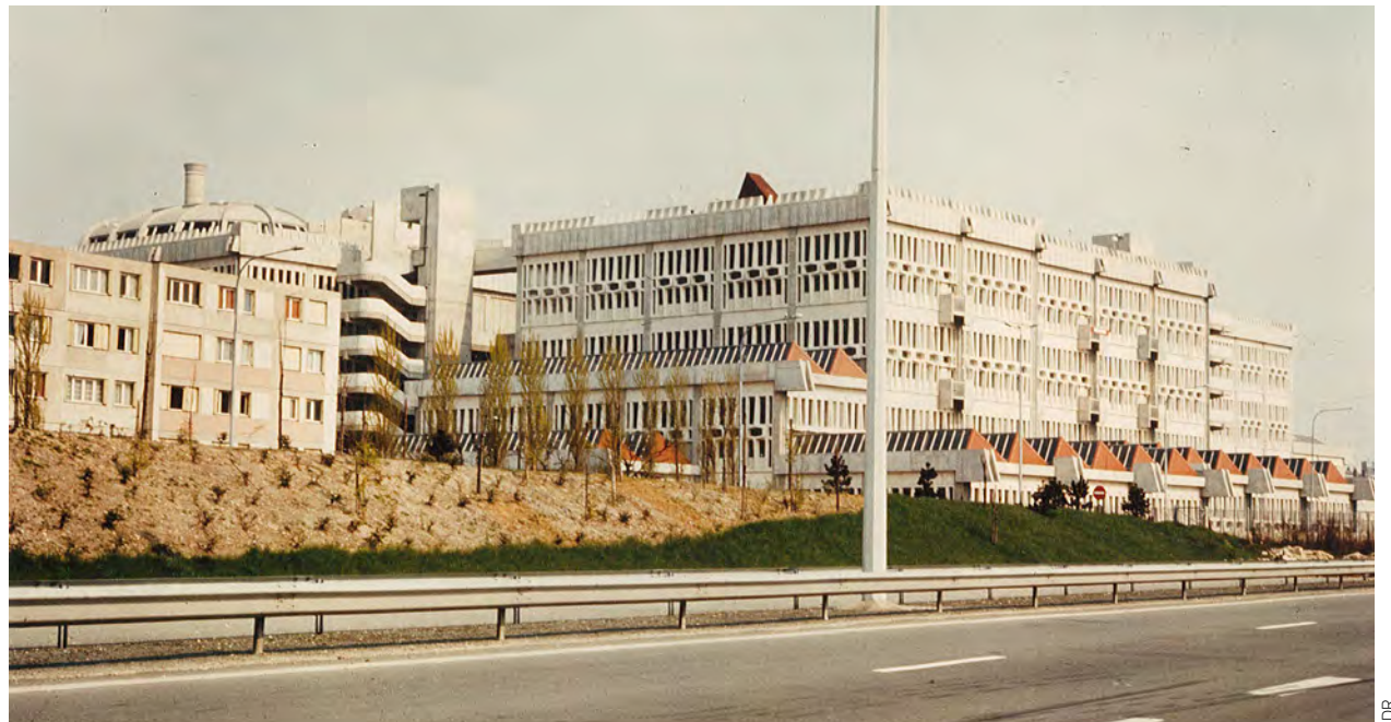
Une vue de l'hôtel industriel Mozinor peu après son inauguration en 1975.
