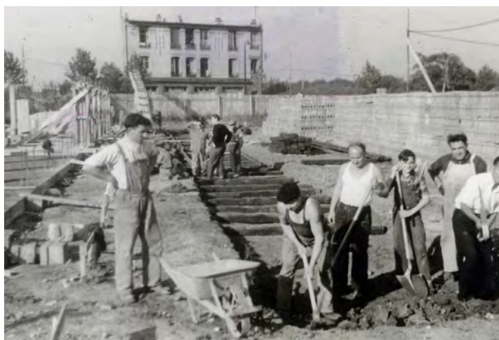
En 1951, au Morillon, on pose les fondations d'immeubles.
