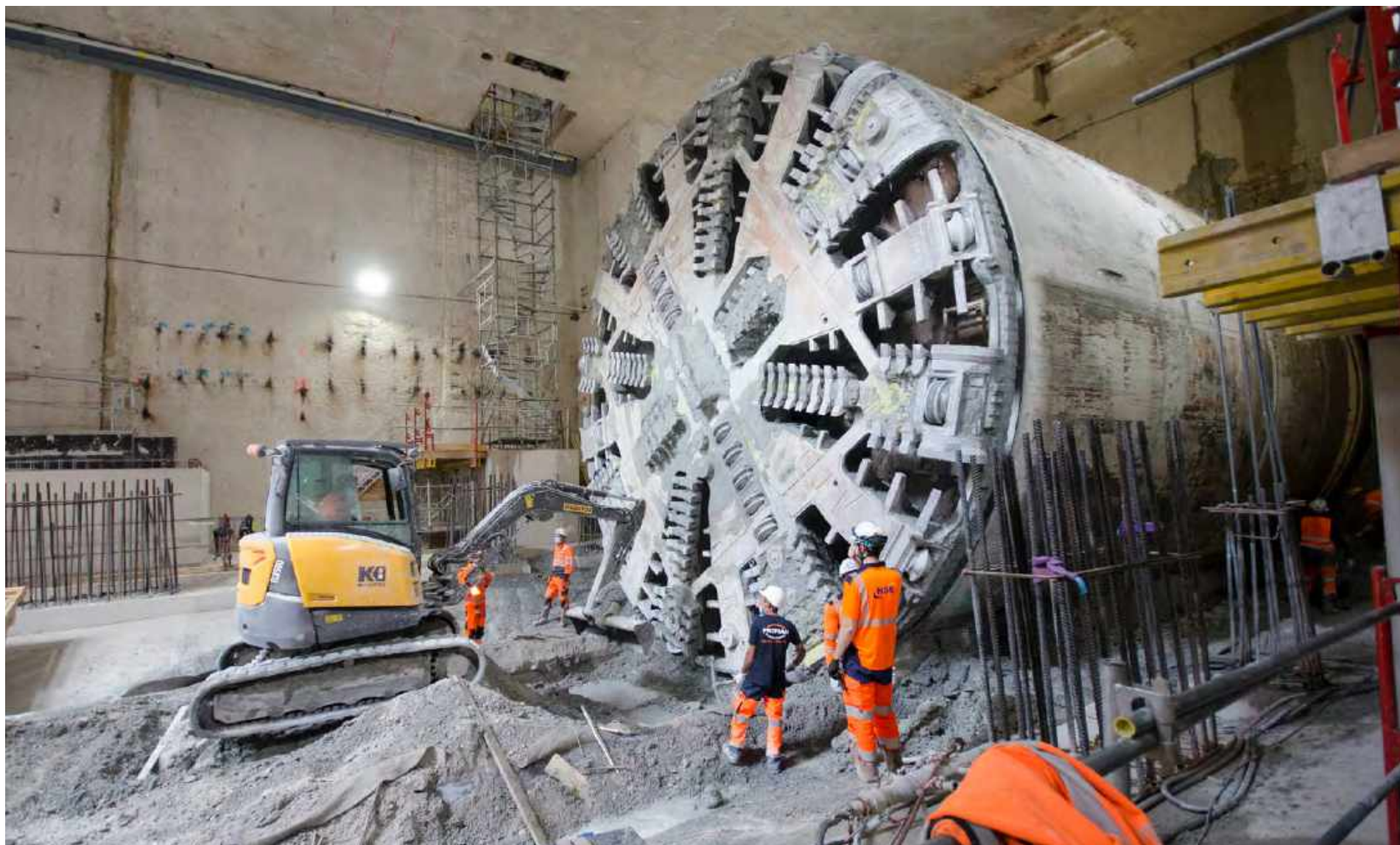
Le tunnelier, avec sa roue de coupe de 9,2 mètres de diamètre, a creusé le prolongement de la ligne 11 jusqu'à la station Montreuil-Hôpital.
