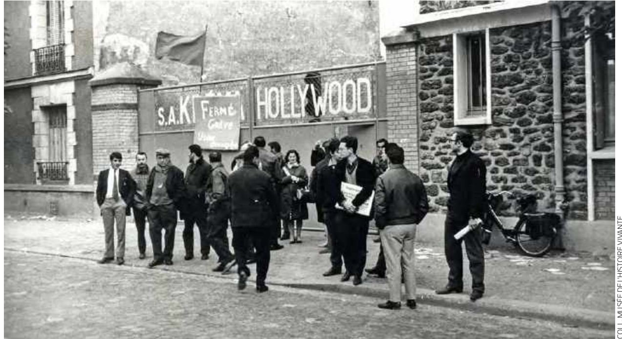
Depuis la fusion de 1955, Kréma-Molié est devenue Kréma-Hollywood. En 1963, le géant américain General Foods s'en empare. En 1968, les employés et ouvriers montreuillois de l'entreprise sont en grève.
