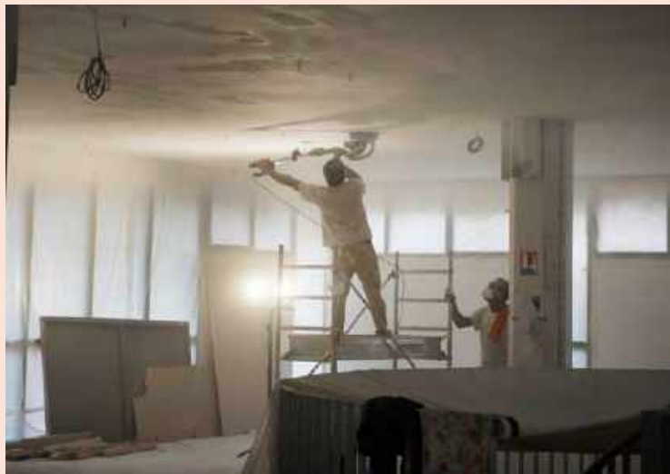
De nouveaux espaces, en tout 300 m 2 de locaux supplémentaires.
