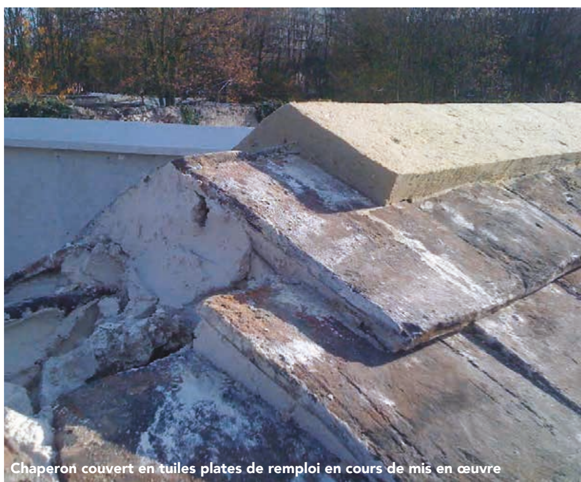
Chaperon couvert en tuiles plates de remploi en cours de mise en œuvre
