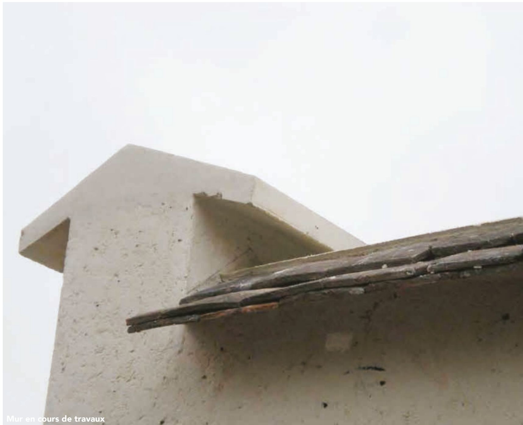
Mur en cours de travaux
