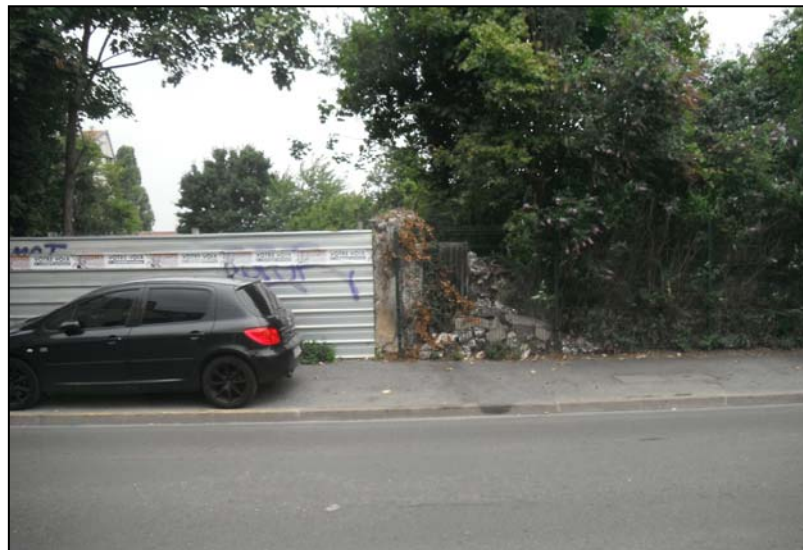
Photographie 10 : Pas d'accès BZ250
