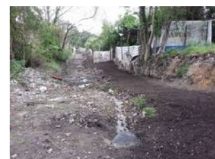
Le chantier en cours
