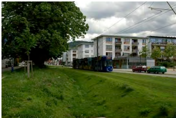
Exemple de noue en ville
