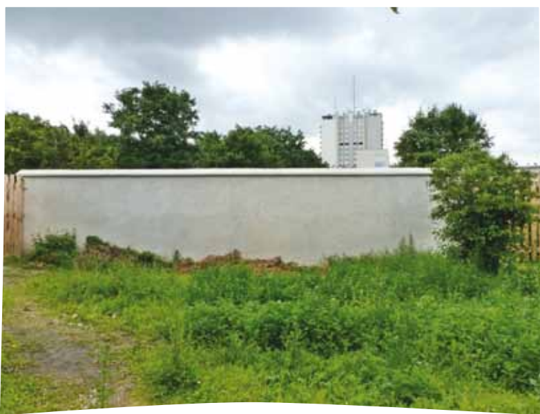
Exemple de mur restauré.
