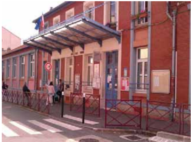
Entrée de l'école Paul Bert avant les travaux :
