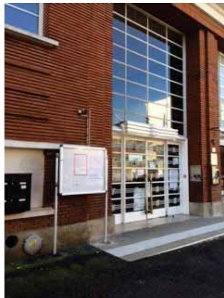
Rampe d'accès aux écoles Voltaire et Héritier
