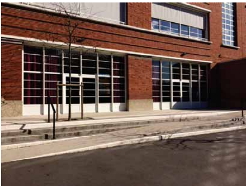
Accessibilité du préau depuis la cour
