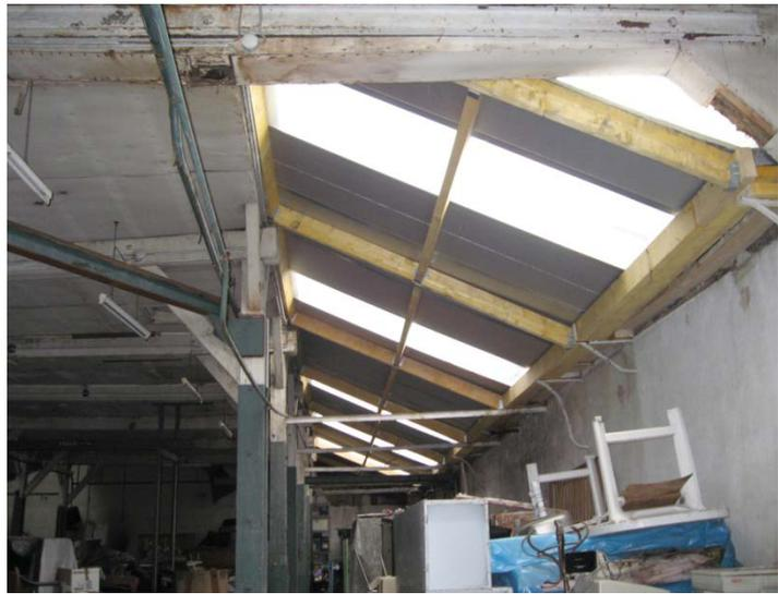
L'enveloppe de ce séchoir a été altérée par des travaux inadaptés de bardage en bac acier.
