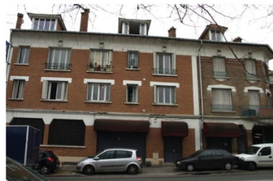
Logements ouvriers et bureaux boulevard Chanzy
