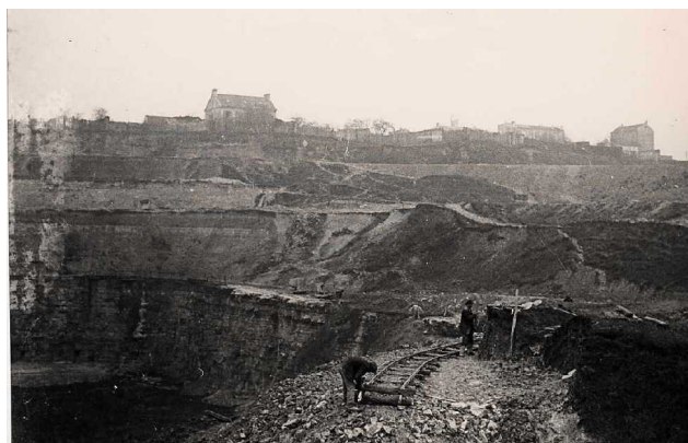
Carrière d'Argile Verte à ciel ouvert, commune de Montreuil Source : IGC
