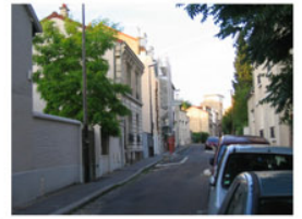
Ambiances de qualités rue Parmentier / rue des Sorins. Ancien tissu maraîcher et habitat modeste.
