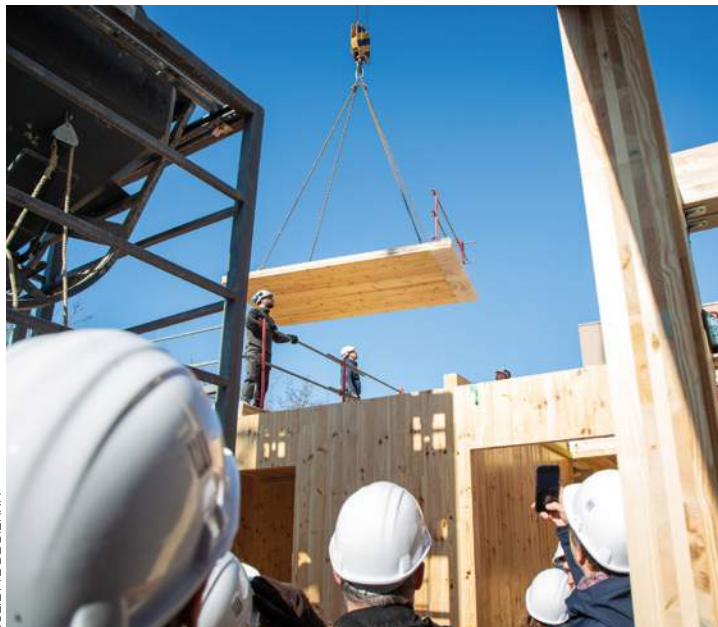
Pose des premières planches, ZAC Fraternité, 14 février 2023.
